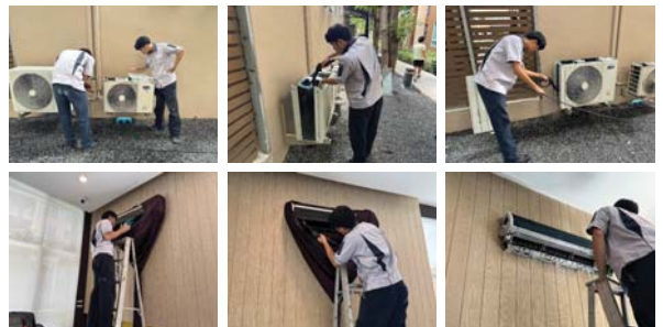
การล้างระบบปรับอากาศภายในโครงการ
