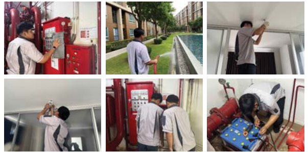
การตรวจ Smoke กับ Fire Pump
